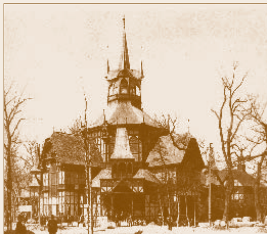
Az erdészeti pavilon épülete a Városligetben
